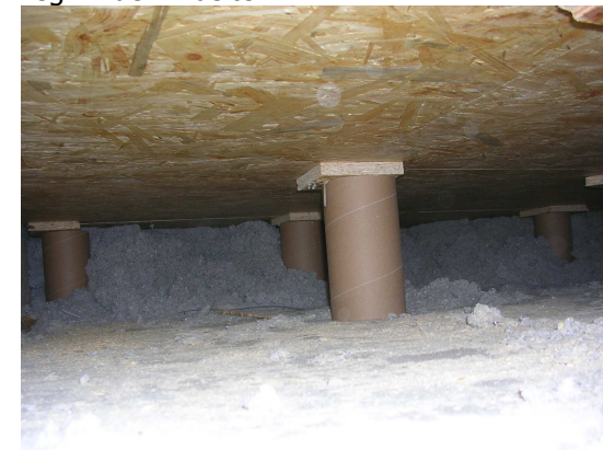
Hülsen-Konstruktion, teilweise gedämmt
