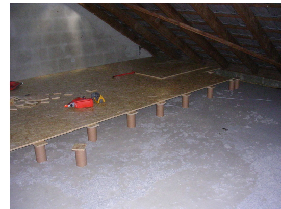
Beginn der Arbeiten
