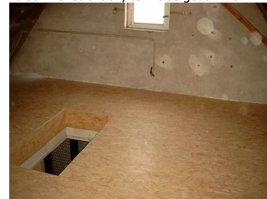
Fertige Konstruktion mit Öffnung der Bodentreppe
