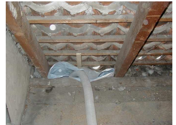
Dämmen des Folienschlauches
