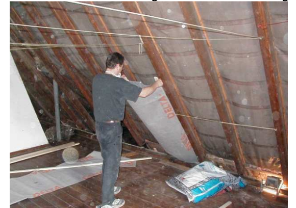
Einführen des Folienschlauches
