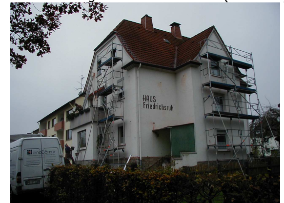
Erstellen der Einblasöffnungen
