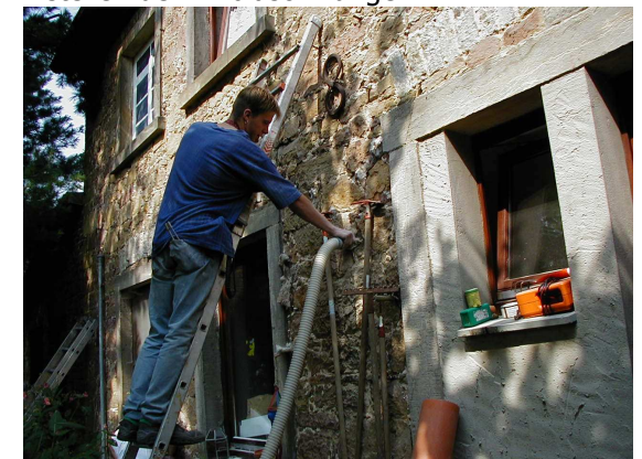
Einblasen des Kerndämmstoffes
