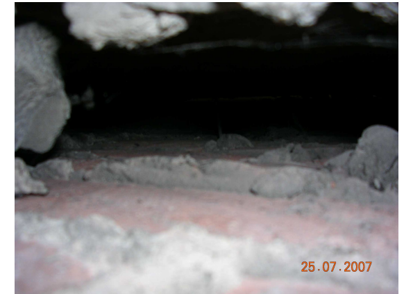
Blick in die ungedämmte Hohlschicht (7 cm dick)
